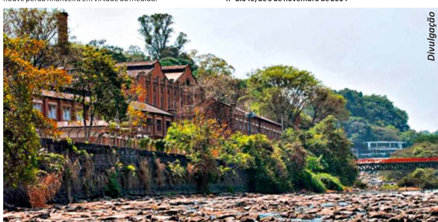
Fábrica desativada às margens do rio Piracicaba (SP), que abastece as indústrias de Paulínia
